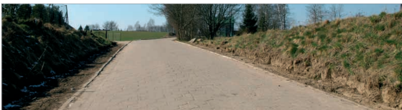
Połęczyno – czyszczenie rowów i poboczy wraz z wycinką krzewów oraz regulacja elementów betonowej nawierzchni na odcinku 1,7 km
