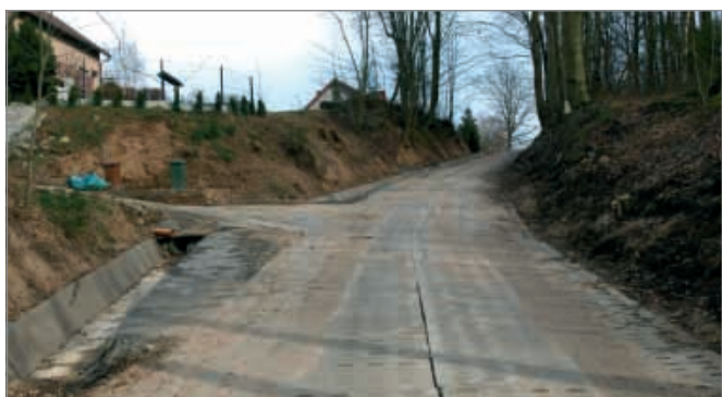
Hopowo – 109 mb, 580 szt. płyt yombo o szer. 4 m wraz utwardzeniem płytkami chodnikowymi rowu
